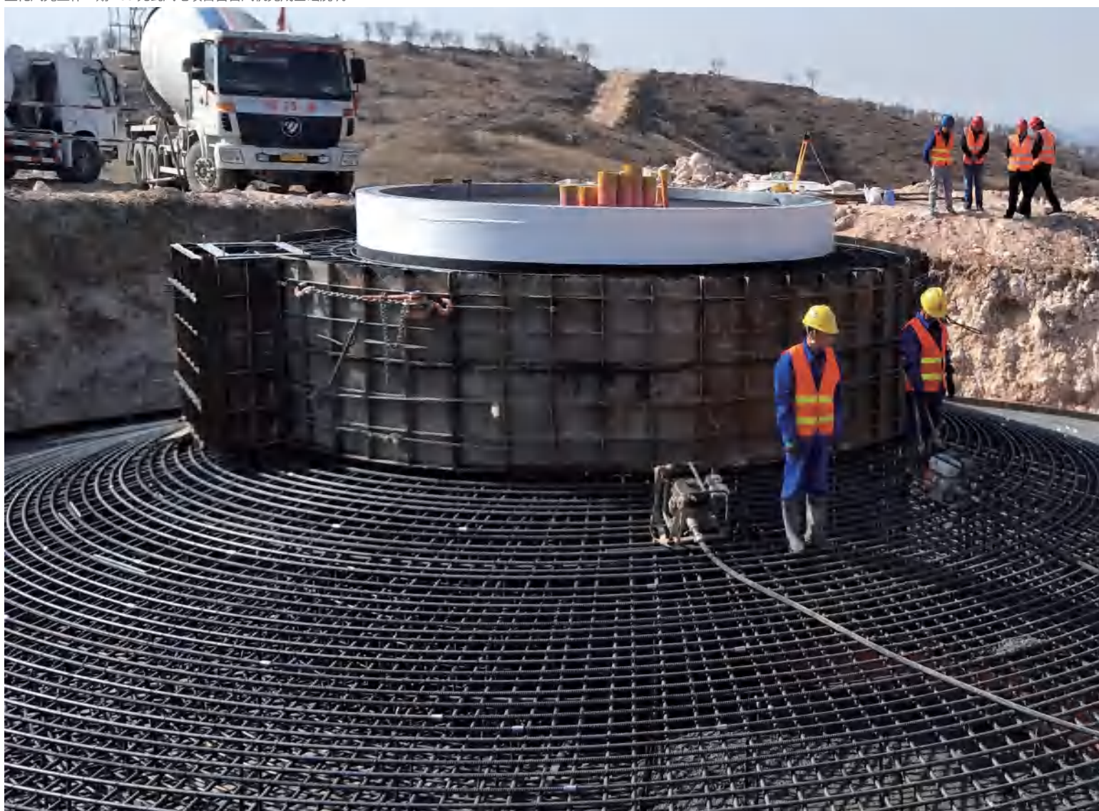
宣化风光互补二期 100兆瓦风电项目首台风机完成基础浇筑
