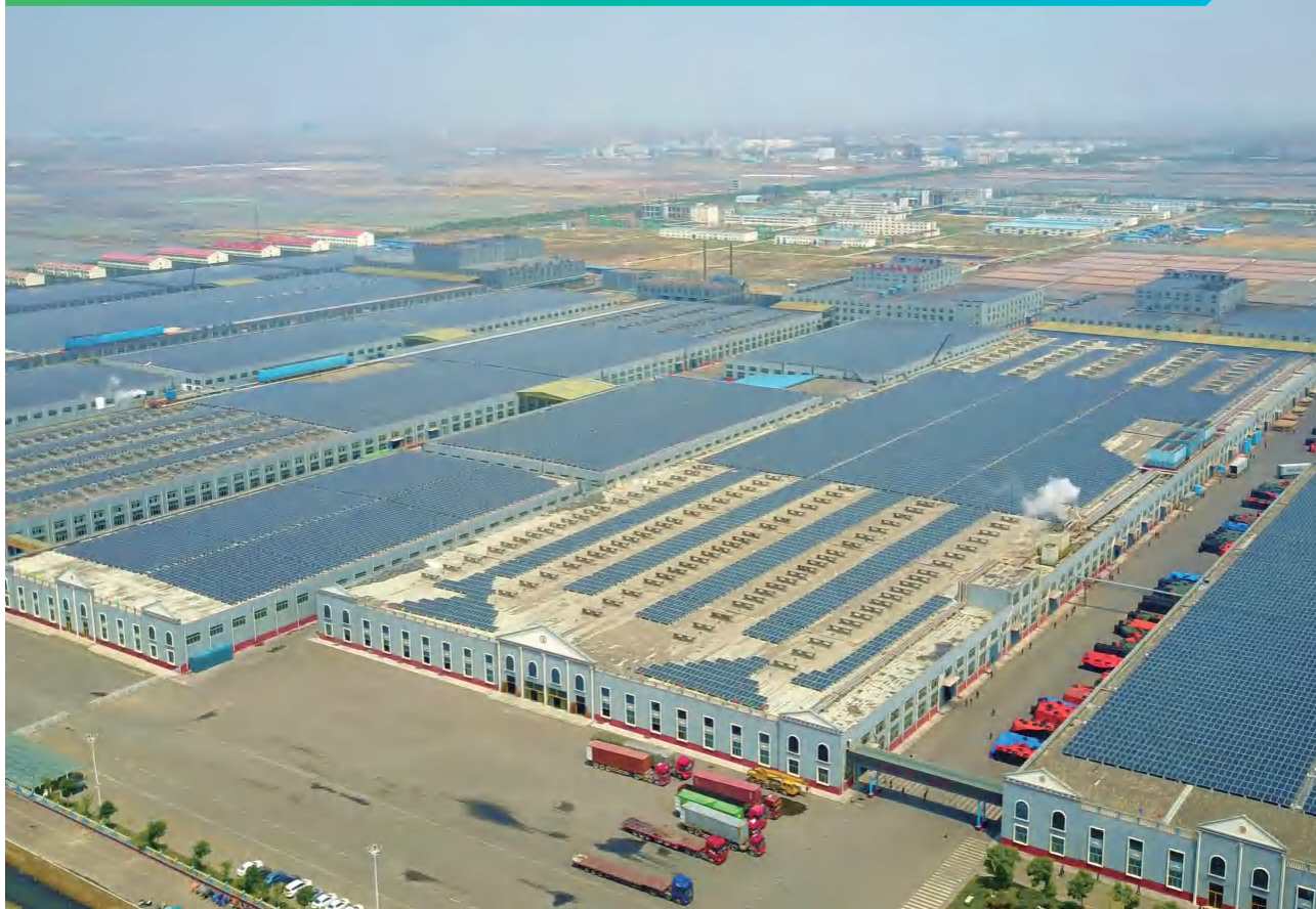
全国最大的屋顶分布式光伏项目——山东吴华一期全景
